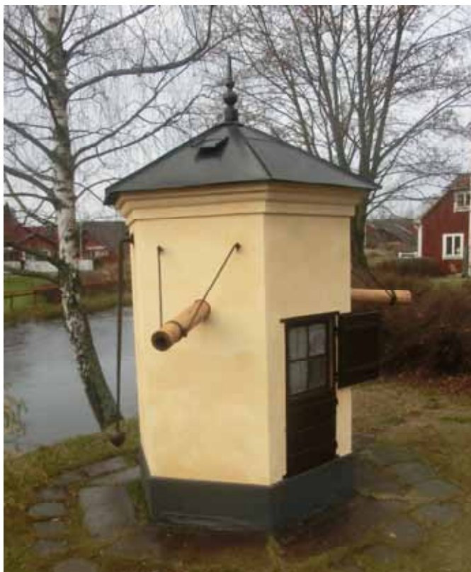
Pumphuset vid Nybron (foto S-E Ejeborg) Läs mer på sidan 42.
