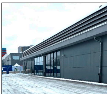
Än så länge består EcoDataCenter av två stålgrå byggnader, men fler kommer, och en kontorsbyggnad håller på att byggas. Foto: Inger Söderlund
