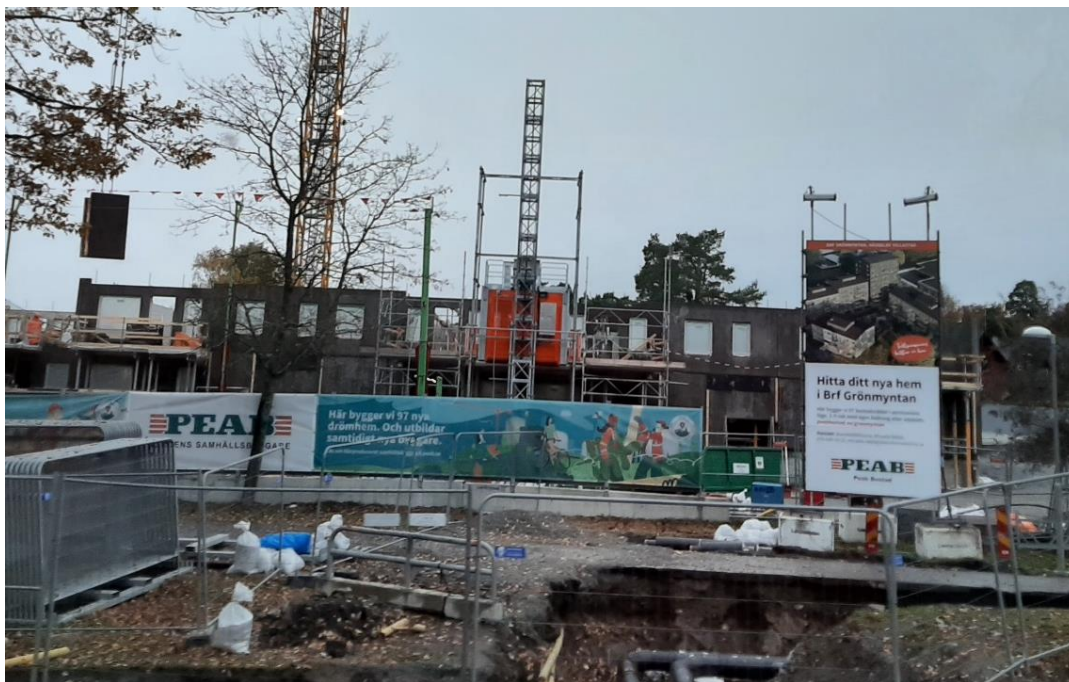
Vid Åkermyntan i Hässelby byggs det för fullt.
